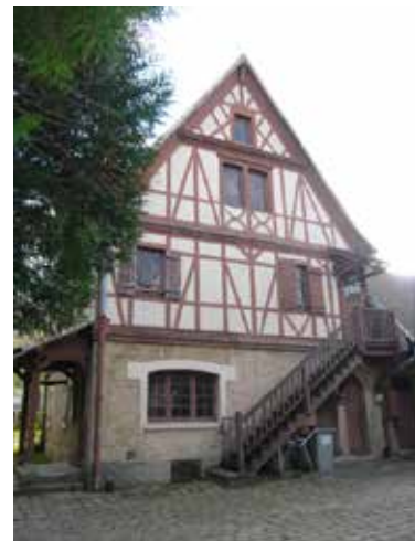
Bâtiment des ateliers
